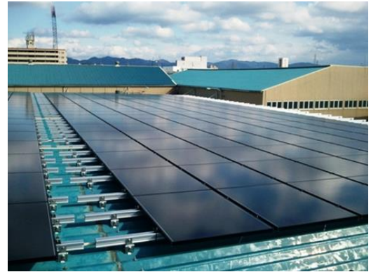
吉川商店の太陽光モジュール840枚で年間15万kwhの発電量。固定買取制度(FIT)を利用し全量関西電力に売電している
