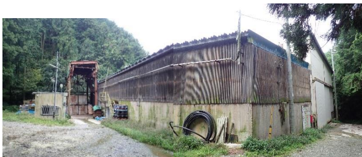
操業停止中の貴島産業千早工場
