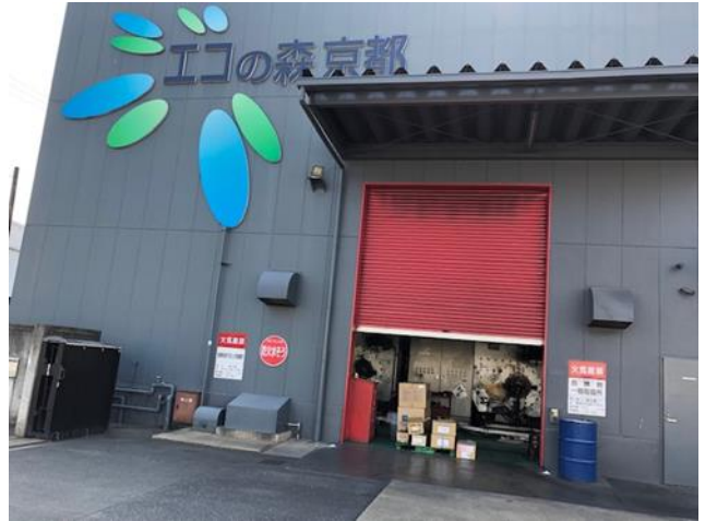
エコの森京都 ボイラー施設
