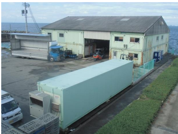
手前は水産倉庫 2 の冷凍冷蔵庫
