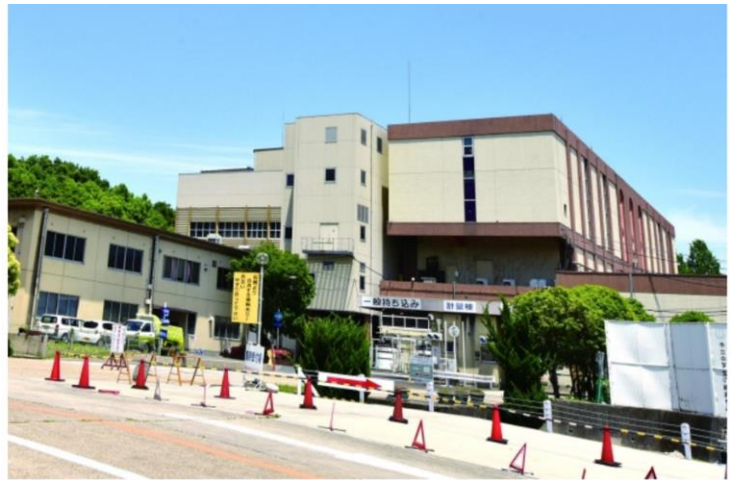
焼却炉などの老朽化が進む環境清美工場＝奈良市左京５（同市提供）
